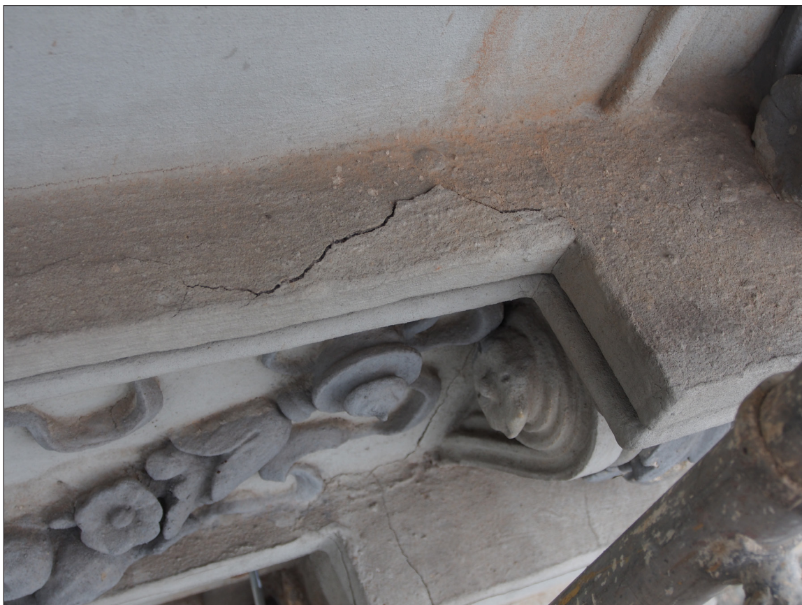
Obr. 22 - Detail horní římsy u prvku RE12/E s hlubokou prasklinou. Výrazné poškození je způsobeno zatěžováním římsy klimatickými cykly a povětrnostními podmínkami.
