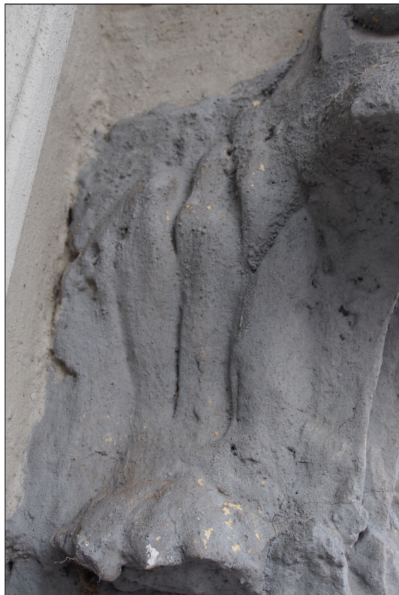
Obr. 30 - Detaily hlavice RE1/B. Neforemná modelace pochází zřejmě z rozsáhlejší rekonstrukce fasády, která probíhala v letech 1969-1974.
