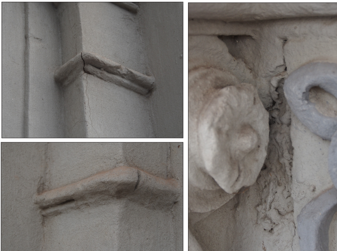
Obr. 39 - Vlevo detail neforemě vymodelovaných drobných římsiček archivolt u okenních otvorů, vpravo špatně opravený defekt mezi prvky RE9/B a RE11/B. Opravy pocházejí pravděpodobně z doby rekonstrukce v letech 1969-1975.
