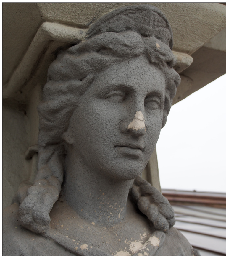
Obr. 12 - Detail hlavy karyatidy RE12/F, modelace povrchu je zaslepena vrstvami nátěrů. Poslední akrylátový je plněn jemným křemičitým plnivem.
