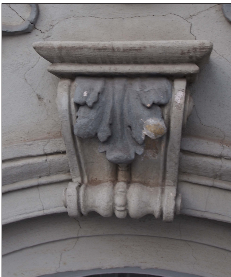
Obr. 36 - Prvek RE3/A. Okolo klenáku jsou ve zdivu viditelné drobné praskliny, které vedou nadokením obloukem až k oknu.
