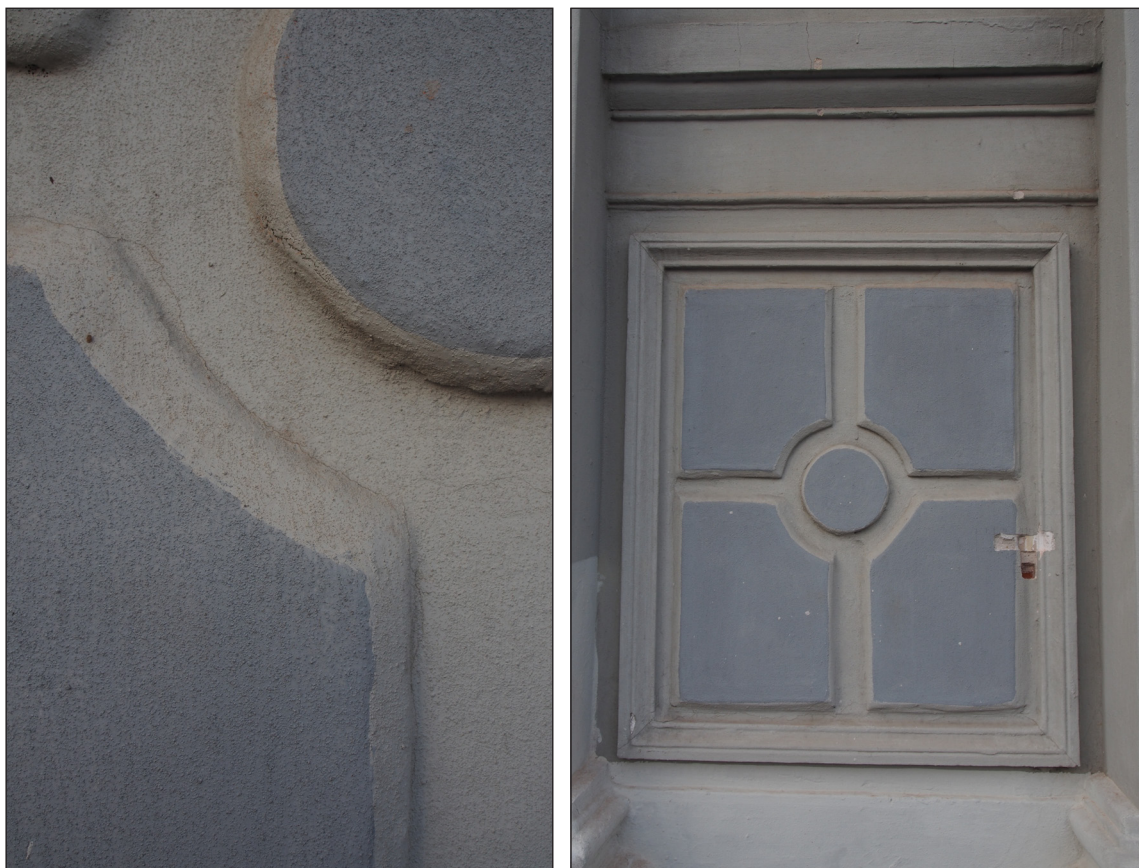
Obr. 40 - Detail geometrického prvku O17/A, profilace je zaslepena vrstvou štuky a nátěrů, k finálnímu silnému zaslepení došlo s největší pravděpodobností v době rekonstrukce v letech 1969-1975.
