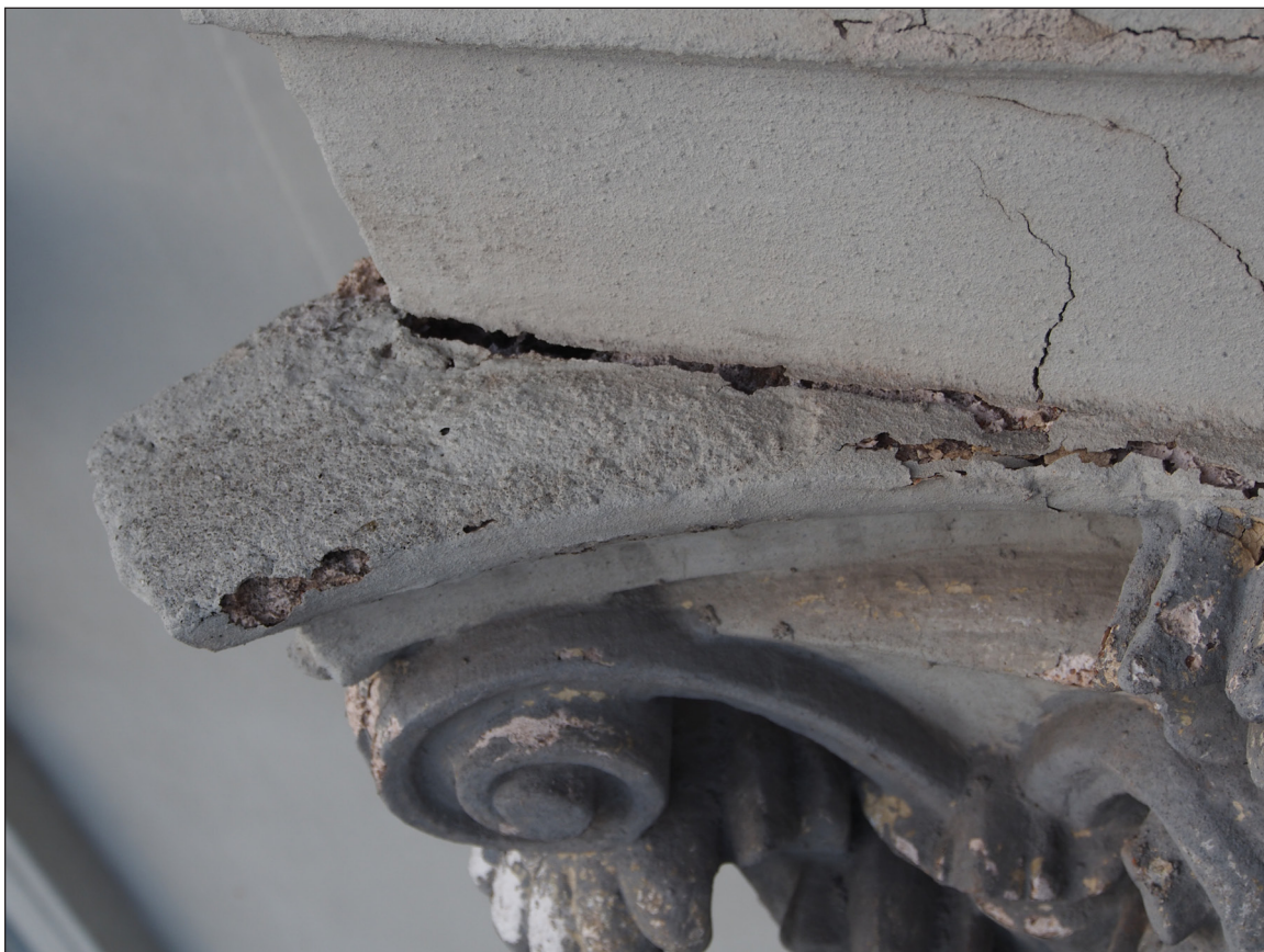
Obr. 27 - Detail hlavice RE1/A, na fotografii je viditelná degradace vrstev nátěrů. Nátěr se zcela odděluje od podkladu, v okolí vznikly drobné praskliny.
