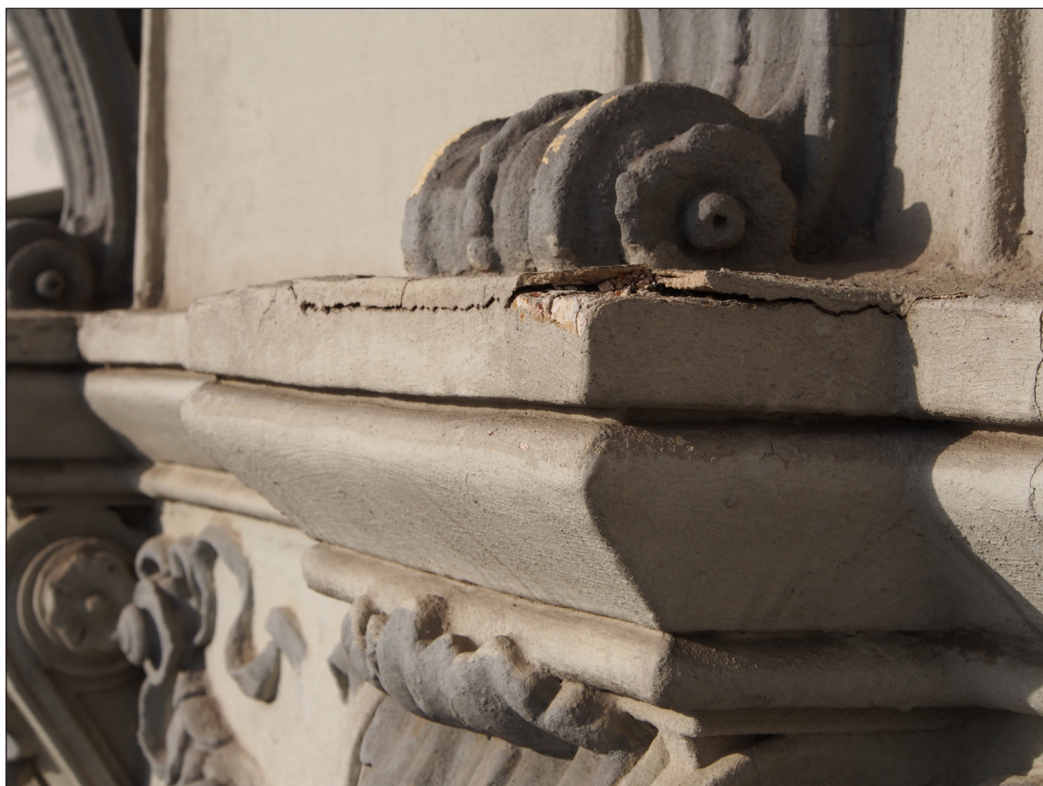
Obr. 24 - Detail římsy u prvku RE12/B. Vrstvy nátěrů s částí omítky se zde zcela odlučují od podkladu.
