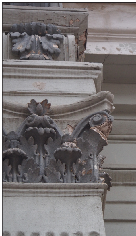
Obr. 28 - konsola RE9/F vlevo, hlavice RE1/F. Oba prvky se nacházejí na okraji fasády, kde jsou extrémě namáhány klimatickými podmínkami. Povrch nátěrů je na této části fasády silně degradovaný. Na římse jsou viditelné hluboké praskliny.
