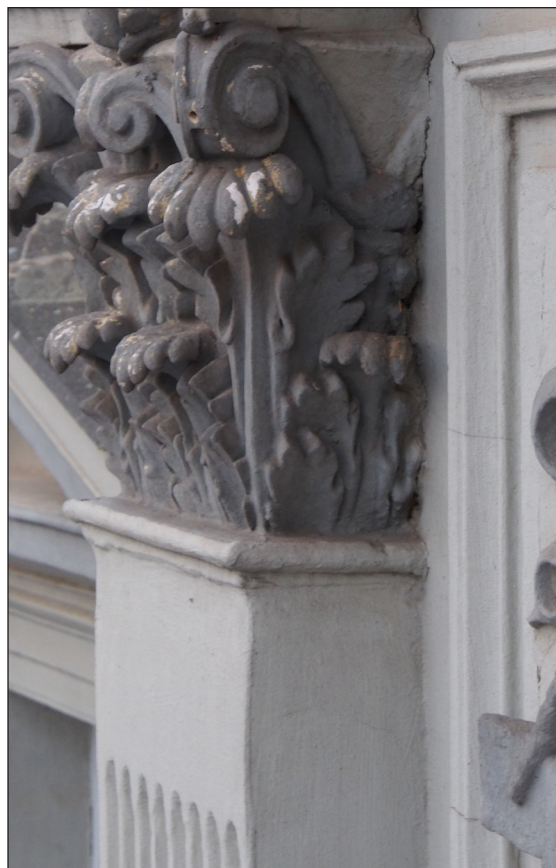
Obr. 31 - Detail pilastru pod hlavicí RE1/B (vlevo), Detail hlavice RE1/A (v pravo). "prstence" zakončující pilastry byly v minulosti neodborně opraveny (pravděpodobně v letech 1969-1975). Na všech pilastrech se jednotlivé prstence liší počtem profilací.
