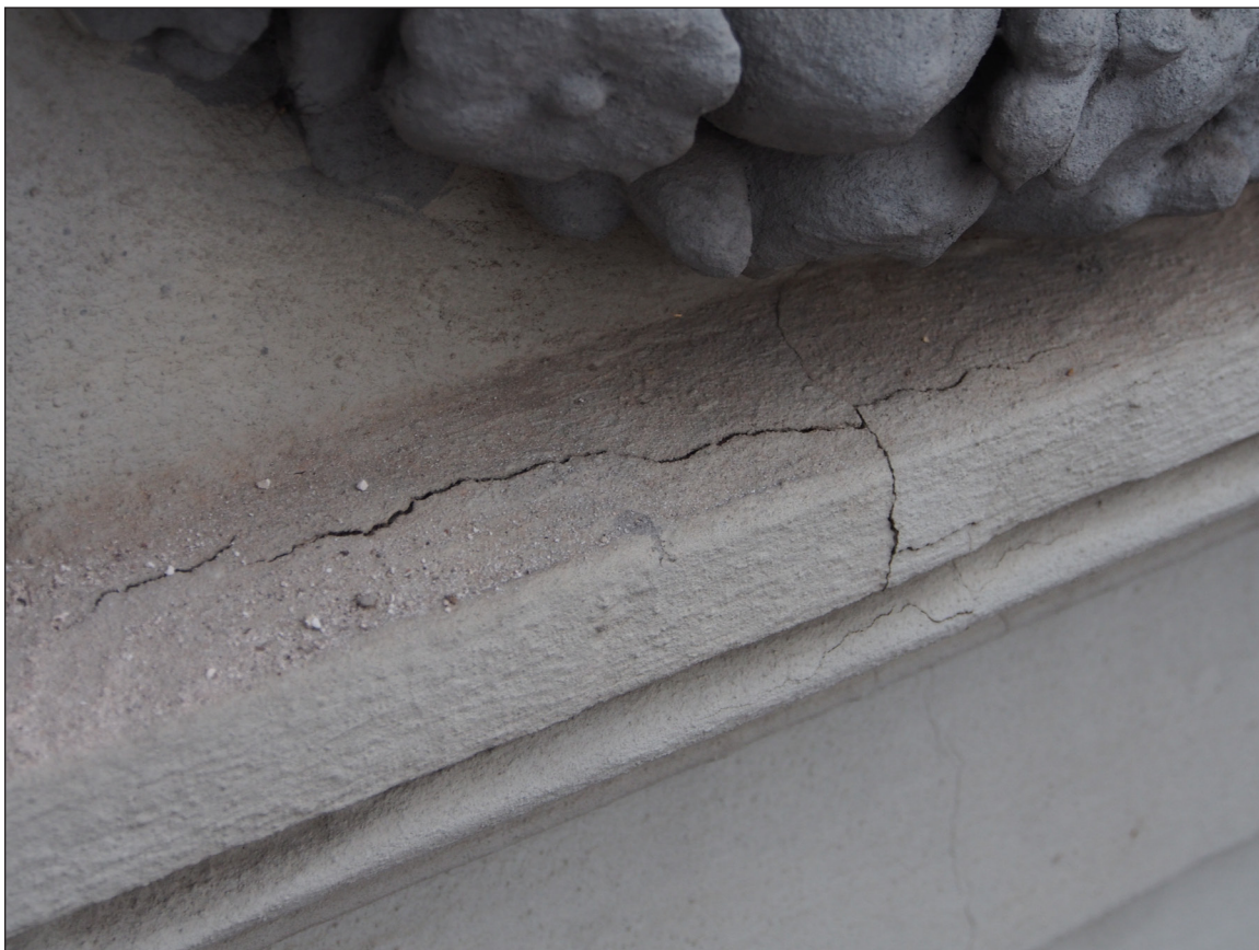
Obr. 25 - Detail hloubkové praskliny, která se nachází na dolní římse pod festonem RE11/G.
