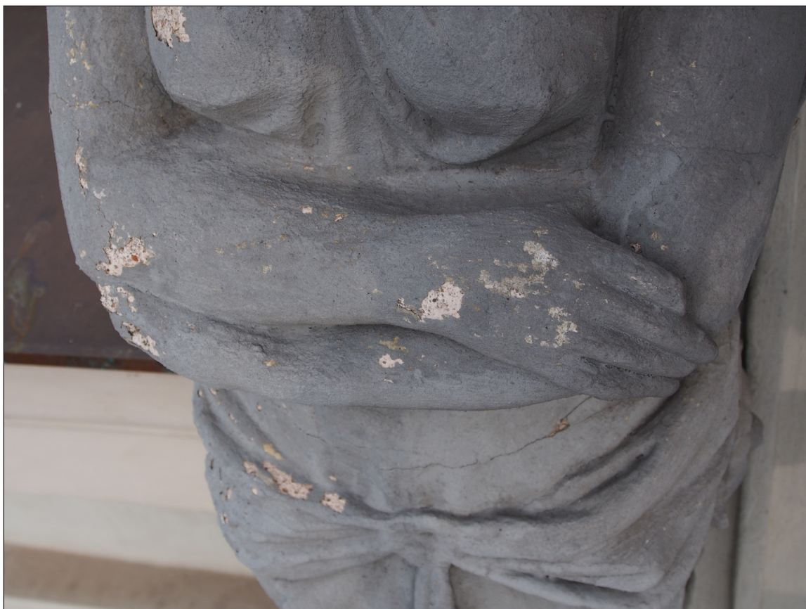
Obr. 13 - Detail rukou karyatidy RE12/A. Nátěry jsou silně degradované v místech, kde nátěr chybí je povrch odlitku narušen do té míry, že jsou zřetelná červená zrnka plniva.
