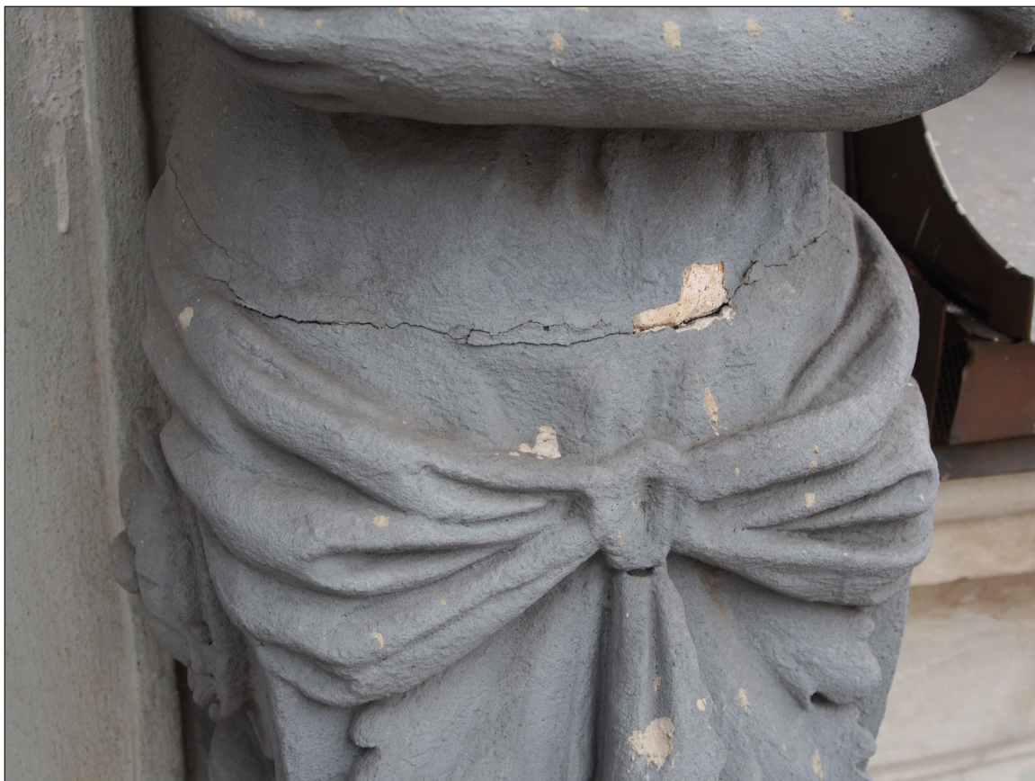
Obr. 15 - Spáry mezi jednotlivými díly sádrového odlitku jsou popraskané, je tomu tak u všech odlitků karyatid.
