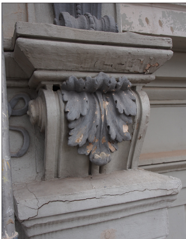
Obr. 28 - konsola RE9/F vlevo, hlavice RE1/F. Oba prvky se nacházejí na okraji fasády, kde jsou extrémě namáhány klimatickými podmínkami. Povrch nátěrů je na této části fasády silně degradovaný. Na římse jsou viditelné hluboké praskliny.
