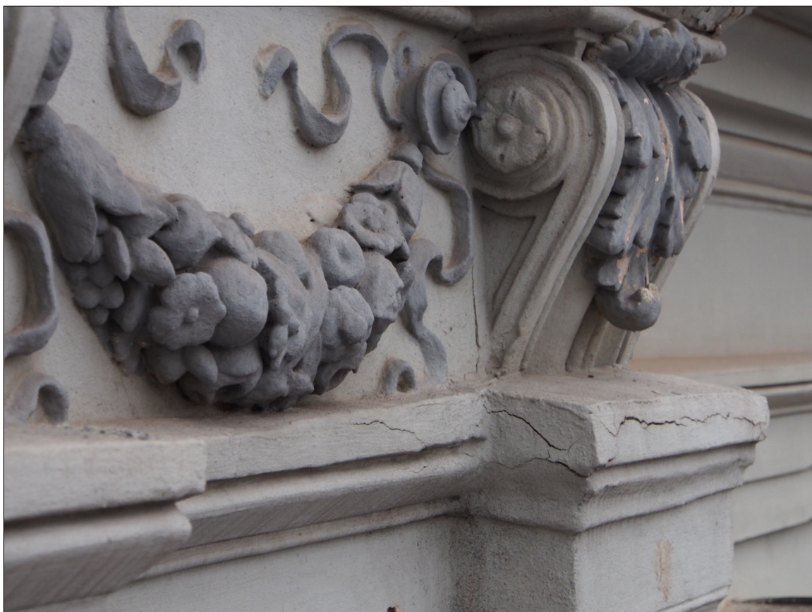
Obr. 26 - Detail hloubkových prasklin na spodní římse u prku RE9/F.
