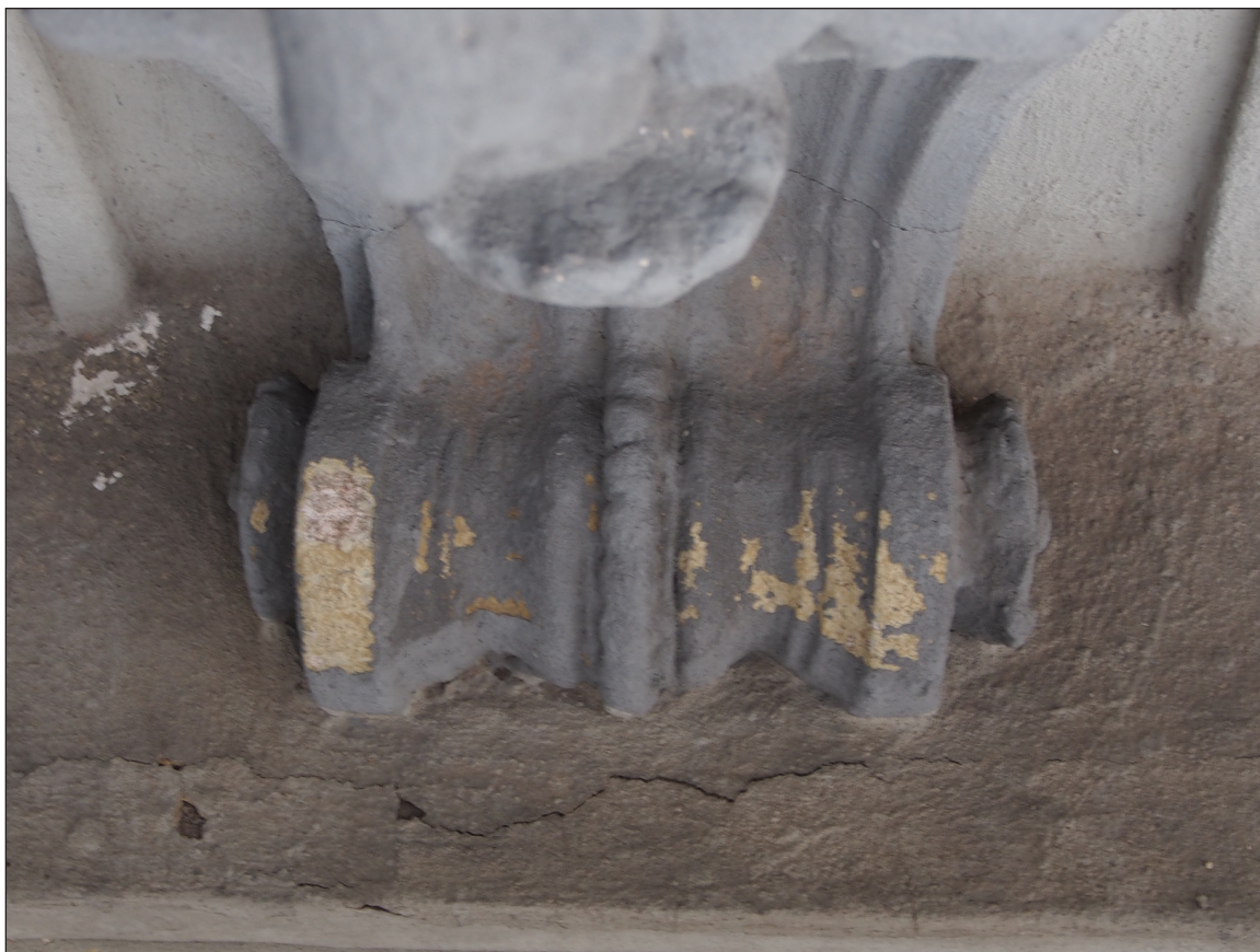
Obr. 17 - Detail voluty s opršelým povrchem, karyatida RE12/C.
