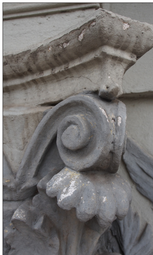
Obr. 29 - Hlavice RE12/A, vpravo detail hlavice. Prvek se nachází na okraji fasády, tato část fasády je více exponována podnebním vlivům proto je po a výskyt prasklin než na jiných částech fasády.
