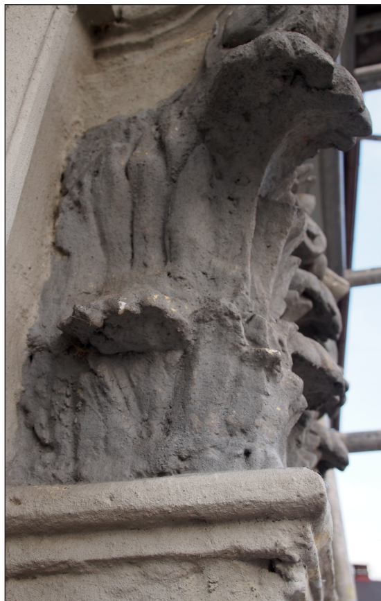
Obr. 30 - Detaily hlavice RE1/B. Neforemná modelace pochází zřejmě z rozsáhlejší rekonstrukce fasády, která probíhala v letech 1969-1974.
