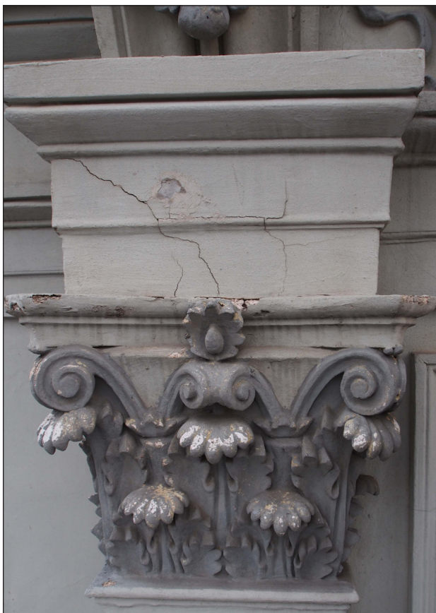
Obr. 29 - Hlavice RE12/A, vpravo detail hlavice. Prvek se nachází na okraji fasády, tato část fasády je více exponována podnebním vlivům proto je po a výskyt prasklin než na jiných částech fasády.
