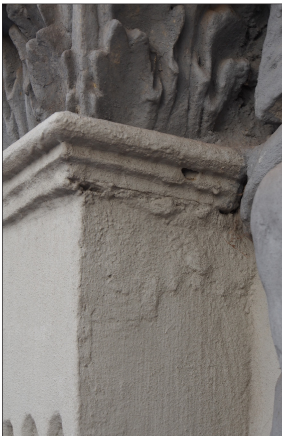
Obr. 31 - Detail pilastru pod hlavicí RE1/B (vlevo), Detail hlavice RE1/A (v pravo). "prstence" zakončující pilastry byly v minulosti neodborně opraveny (pravděpodobně v letech 1969-1975). Na všech pilastrech se jednotlivé prstence liší počtem profilací.
