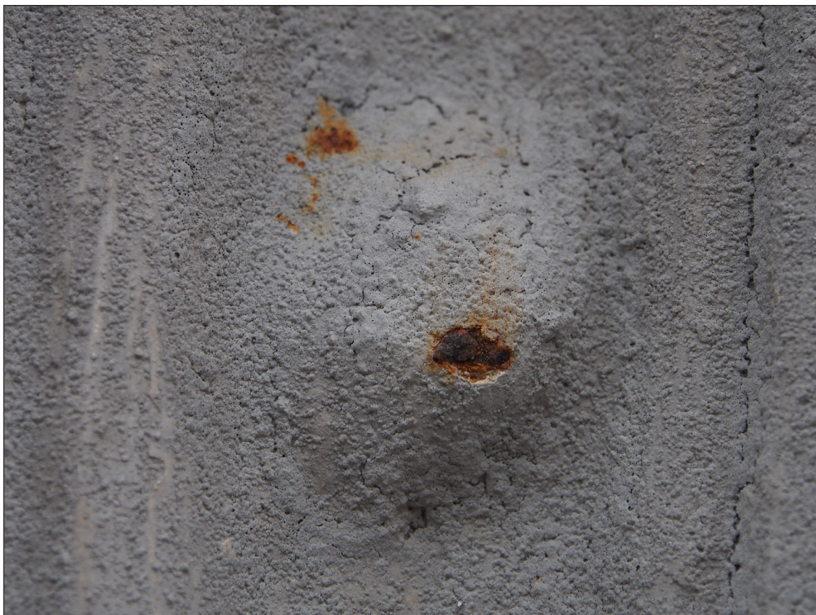
Obr. 16 - Detail koroze hřebu, kterým je část odlitku karyatidy upevněna k fasádě.
