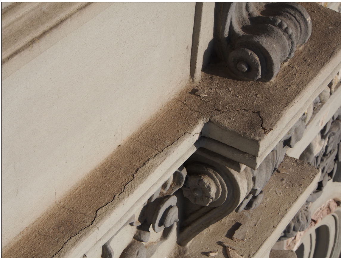
Obr. 23 - Jedna z dlouhých hlubokých prasklin na hraně horní římsy.
