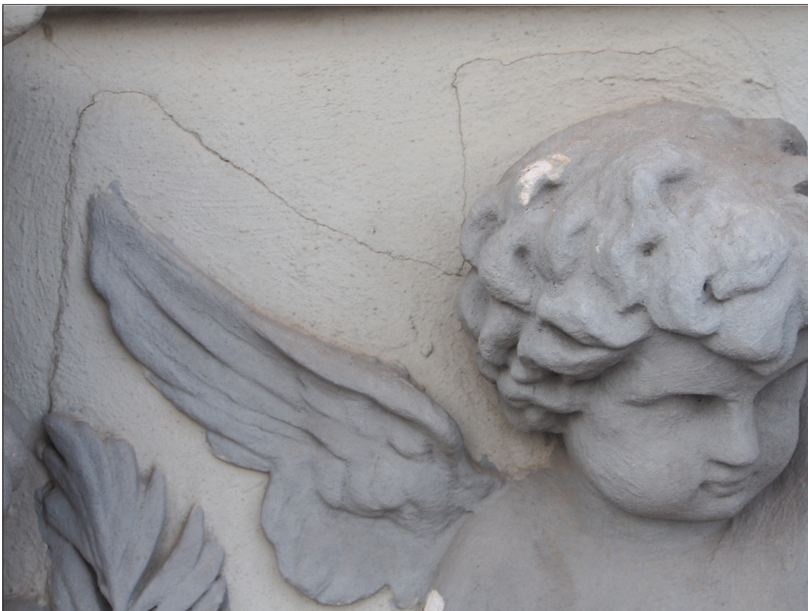
Obr. 33 - Praslina vzniká v místech dělící roviny mezi odlitkem a štukovým polem, vlivem odlišných vlastností sádky a štuku (prvek RE4/B).
