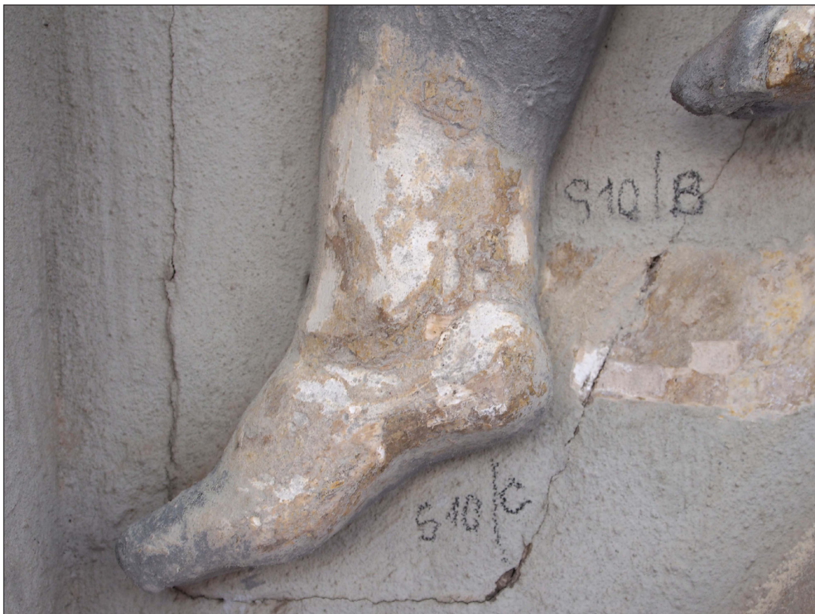
Obr. 41 - Detail levé nohy anděla, prvek RE4/A. Po odstranění akrylátového nátěru, jsou viditelné částečně odstraněné starší vrstvy barevných nátěrů, lokálně prosvítá povrch originálu. Takto v minulosti očištěné povrchy se pravděpodobně nacházejí pouze v dolních partiích této části fasády.
